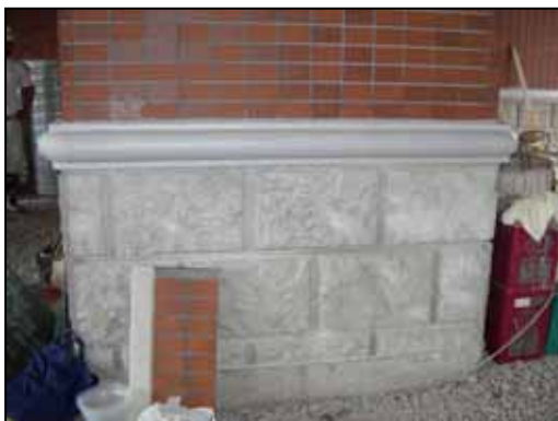
腰壁塗装前 コンクリート
