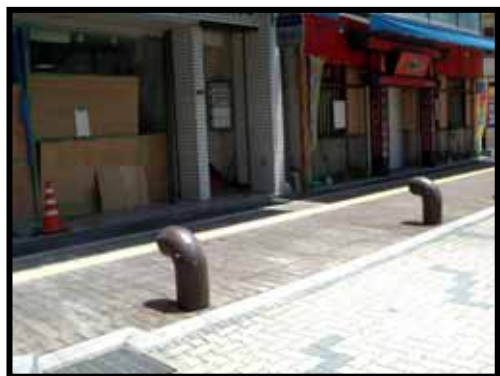
c地点施工状態
