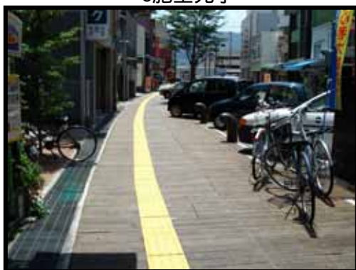
a施工完了
