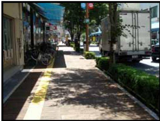
c施工完了
