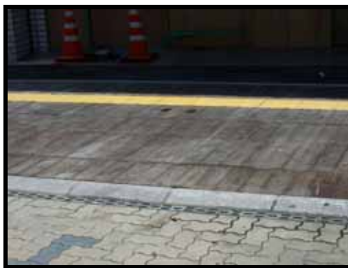
c地点施工状態
