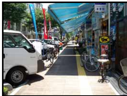
d施工完了
