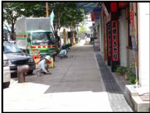
e地点下地処理
