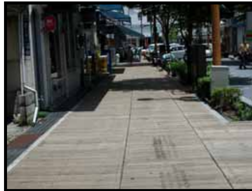
c施工完了
