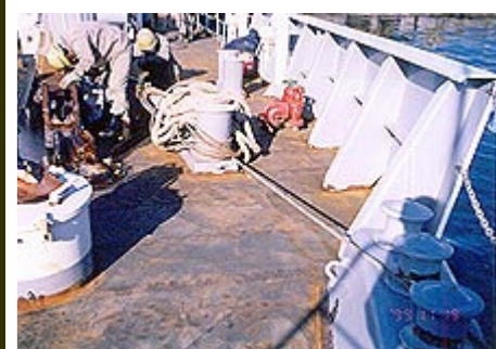
高圧洗浄により塗膜及汚れを除去
