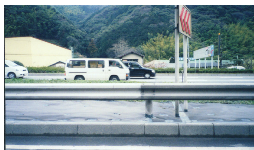
光触媒・施工有り 施工無し 国道1号線ガードレール（施工後1年以上） （大成ロテック様）
